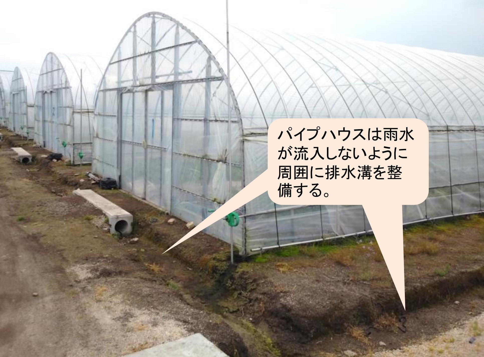
パイプハウスは雨水が流入しないように周囲に排水溝を整備する。
