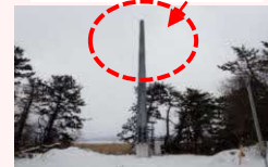
<風車の羽根の脱落>
