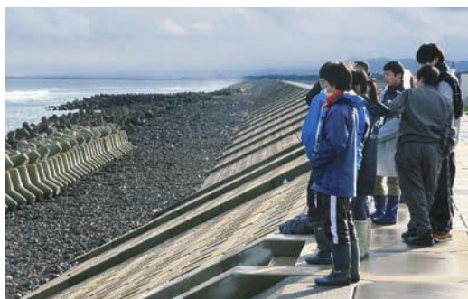
実際に被災地（宮城県）へ行き、防潮堤に自らの足で立つ
