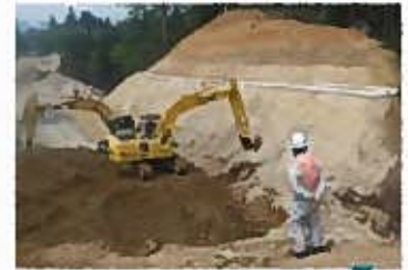
ICT土工（無人化施工）
