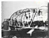
日野橋の工事 昭和4年5月頃
