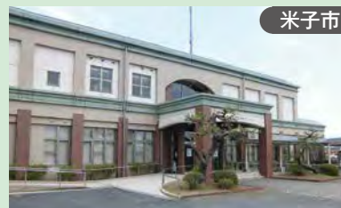
米子市 西部地区運転免許センター
