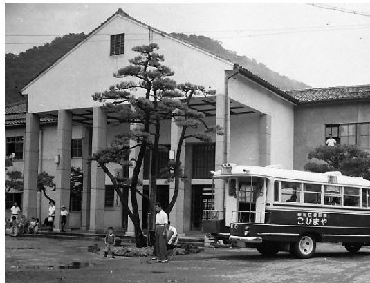
昭和19年建築の庁舎（3代目）
