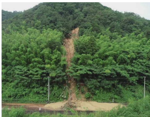
土砂崩落(倉吉市円谷)
