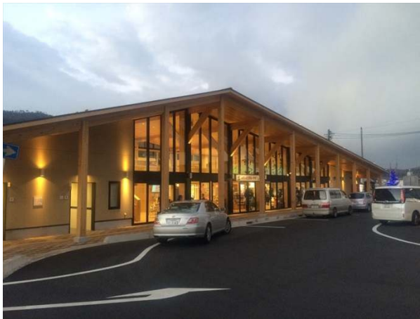
鳥取県産の木材をふんだんに用いた駅舎。大空間の交流スペース、2階には展望スペースがある。
