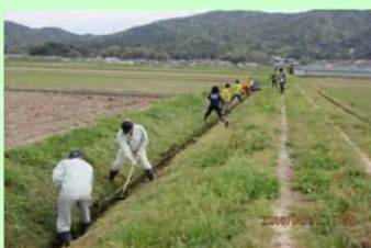
水路の泥上げ作業
