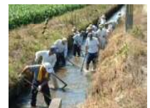
水路の泥上げ
