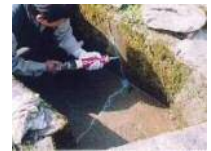
水路のひび割れ補修
