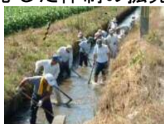
水路の泥上げ
