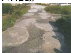
農道の窪みの補修
