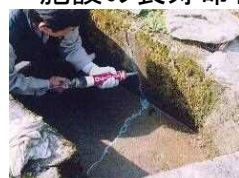
水路のひび割れ補修
