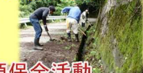
水路の泥上げ
