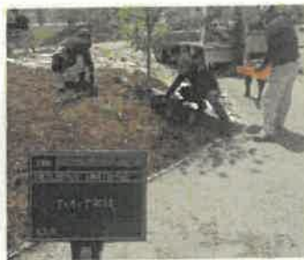
【チップ敷均し状況】
