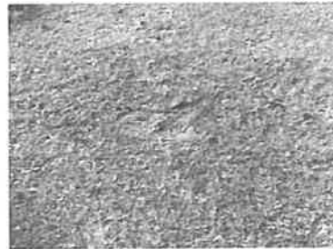
砂をかけ補修完了
