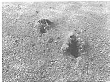
ハンマー投げによる損傷
