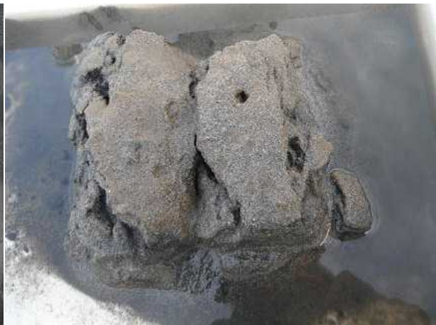
H21試験施工区
