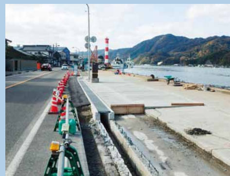
係留岸壁の高潮対策工事 (境漁港)
