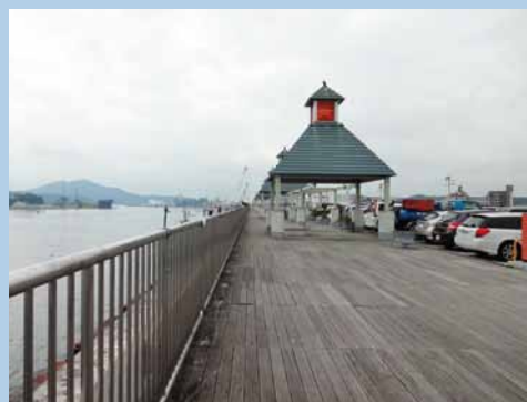
屋上駐車場の整備 (宮城・気仙沼漁港)
