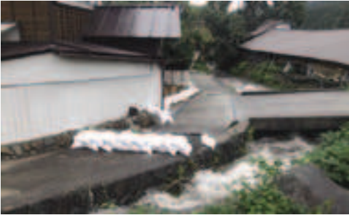
▲ 平成 25 年の台風 12 号による被害
