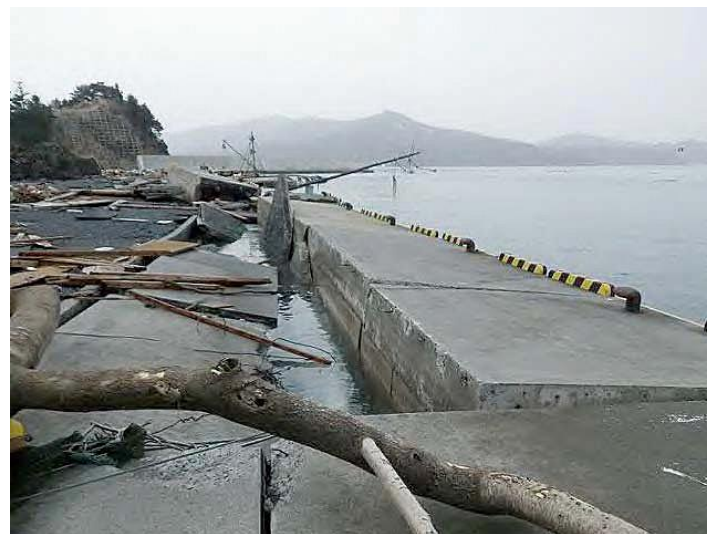
東日本大震災で被災した漁港(宮城県石巻市)
