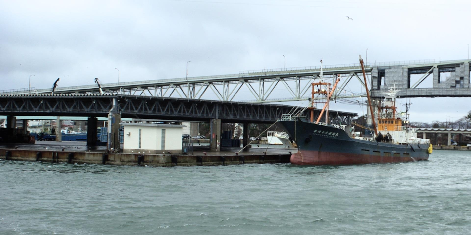
3・4号岸壁（現況写真）
