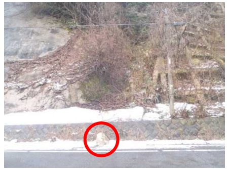
▲落石の発生状況
