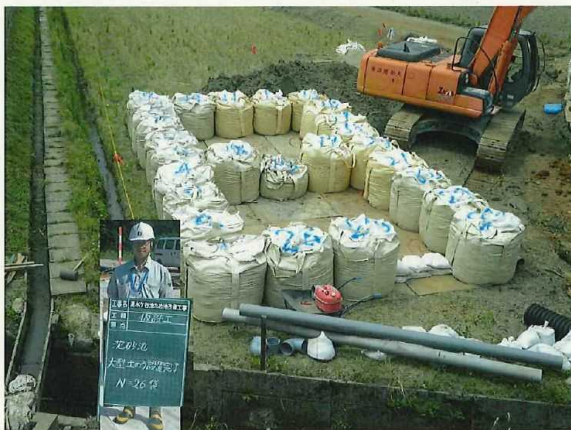
大型土のう設置状況
