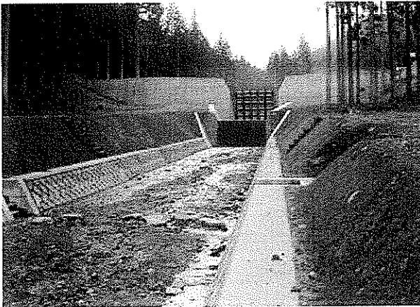
【治水（砂防）】砂防堰堤・谷止工の設置
