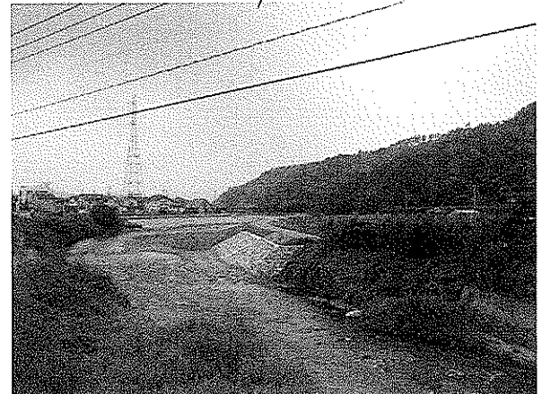
【河川改修】河床掘削、護岸整備
