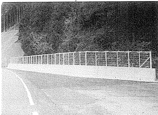
【道路防災】落石防護柵の設置
