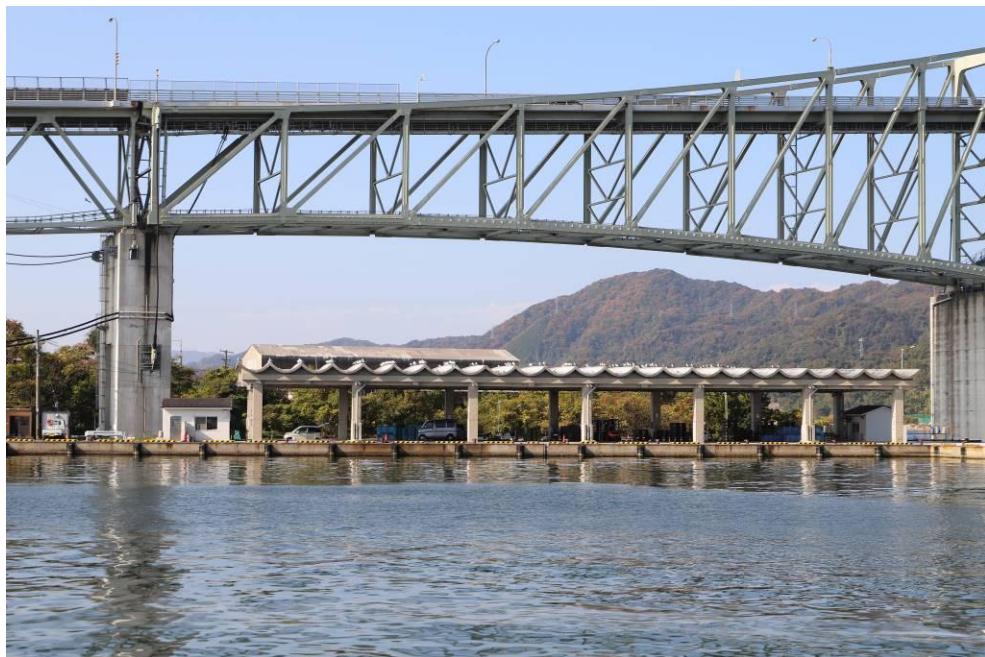
荷さばき所（7号上屋）（令和3年11月18日撮影）
