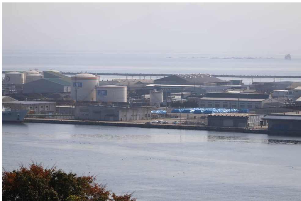
荷さばき所（8号上屋）（令和3年11月18日撮影）
