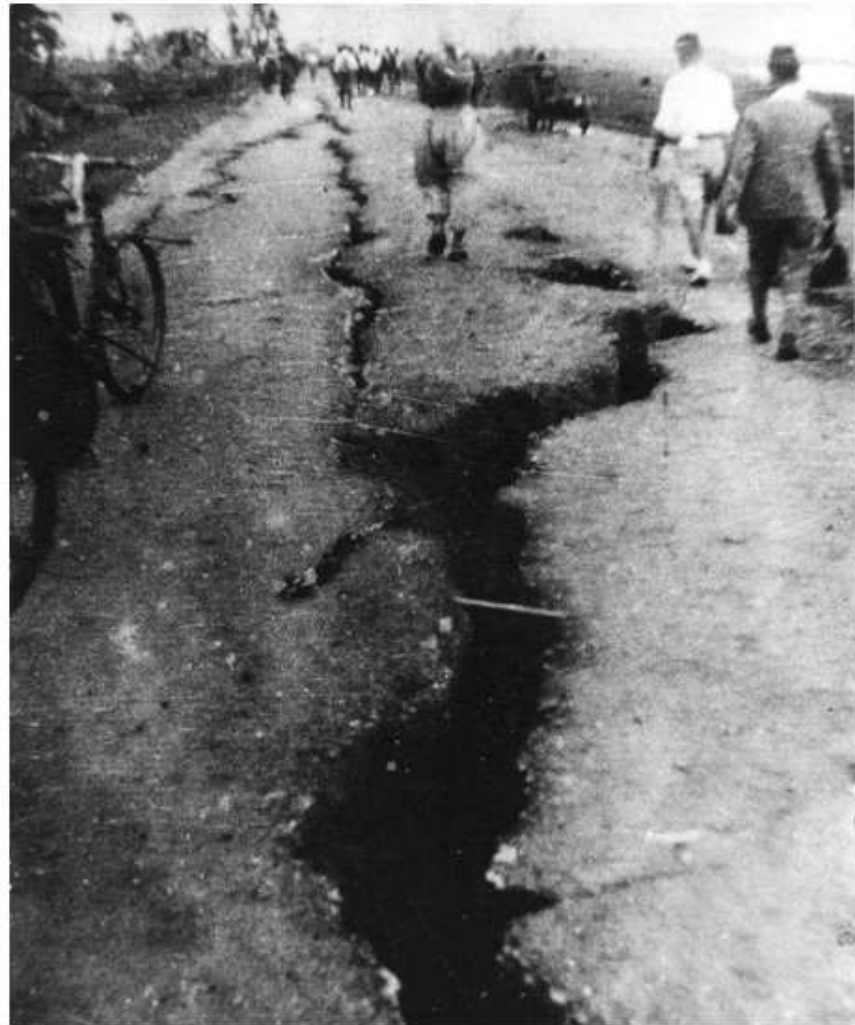
道路の地割れ
