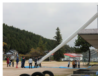
脱出シューター出口
