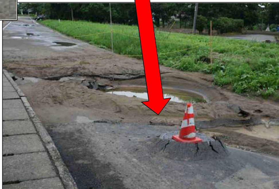
【被害写真：中越沖地震(平成19年)】
