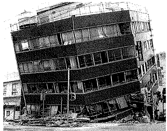
▲こわれたビル：阪神・淡路大震災／平成7年(1995年) *写真提供：神戸市
