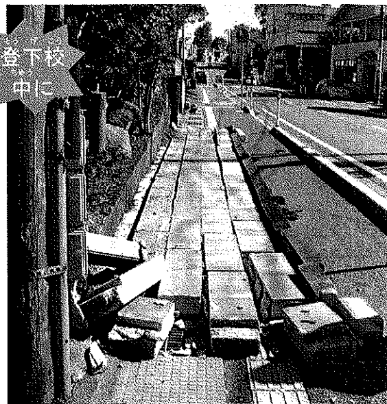
▲地震で倒れたブロック塀 : 新潟県中越地震／平成16年(2004年) *写真提供: 東北大学災害制御研究センター
