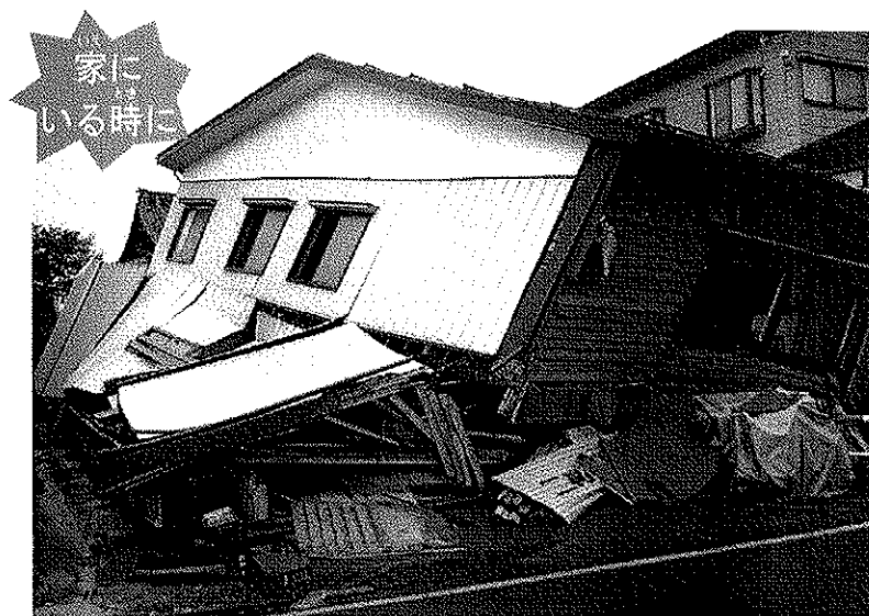
▲1階がつぶれてしまった住宅：新潟県中越地震／平成16年(2004年) *写真提供: 首都大学東京土質研究室
