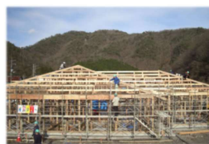
非住宅建築物
