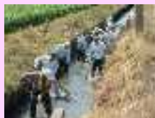
水路の泥上げ
