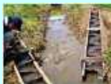
水田魚道の設置
