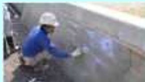
老朽化した水路壁のコーティング
