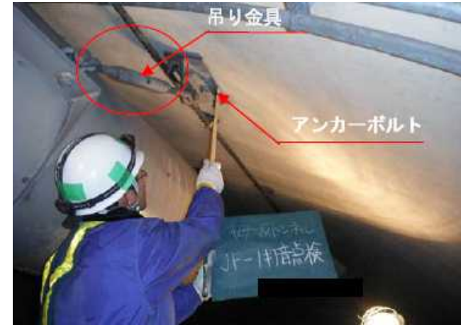
打音調査作業状況
