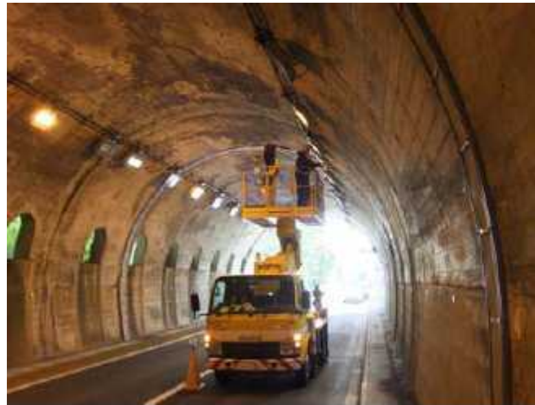
近接目視作業状況
