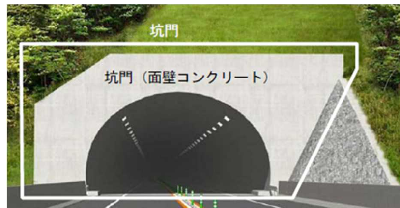
別図-1.2 点検対象箇所(トンネル坑口部)
