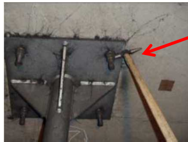
打音検査の例
