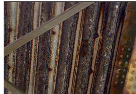
主梁のウェブや支点部付近で著しい断面欠損や広範囲に大きな板厚減少が生じている場合
