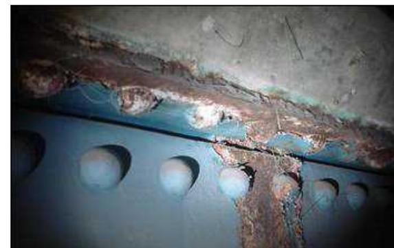
頂版下面に漏水などによる腐食が進行しており、放置すれば急速に板厚減少や断面欠損などが生じる恐れがある場合
