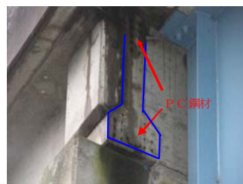
プレT桁端面のPC鋼材腐食事例
