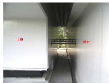
桁端部遊間確保と塗装事例
