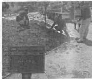
【チップ敷均し状況】
