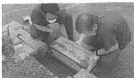
職員による道の駐車場縁石補修
