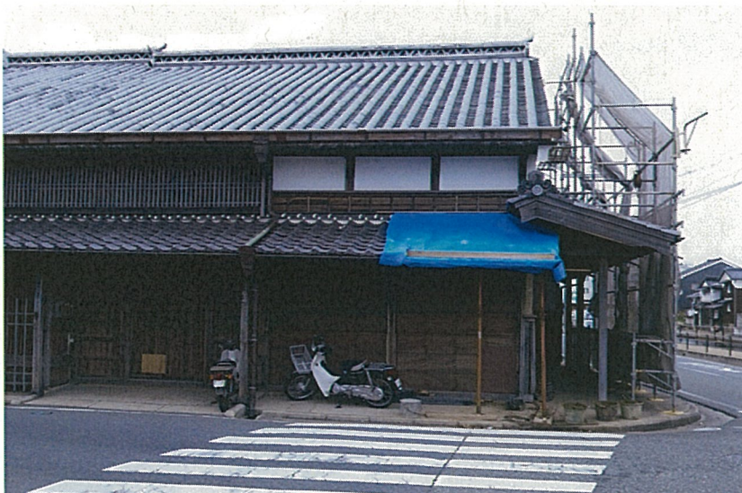
応急処置後の様子
