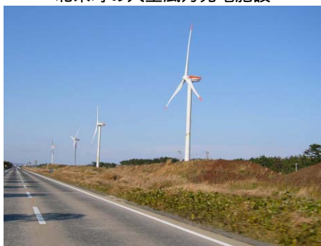
北栄町の大型風力発電施設
