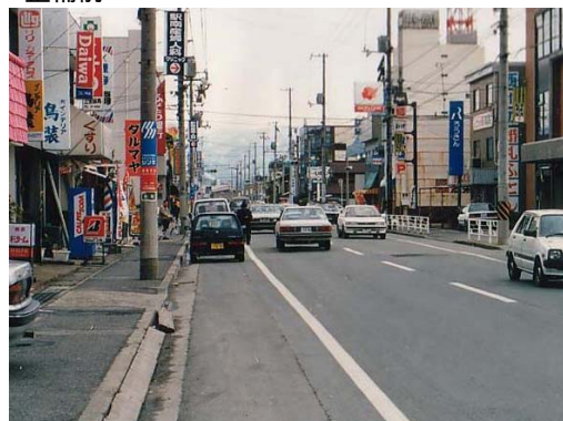
電線共同溝・街路整備の例 (都市計画道路宮下十六本松線 鳥取駅南周辺) 整備前
