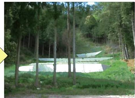
崩壊地の復旧を図るため、山腹工を実施し、森林の機能回復を図った。
