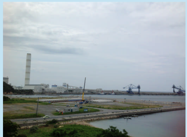
【三隅火力発電所】
