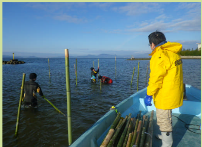
竹林礁の設置作業風景（平成24年12月27日）
