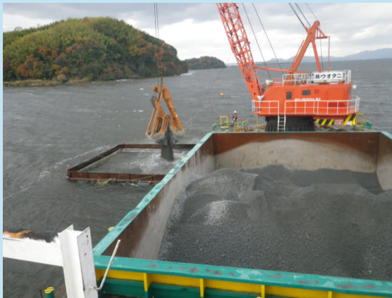
浚渫窪地へのHiビーズ投入
