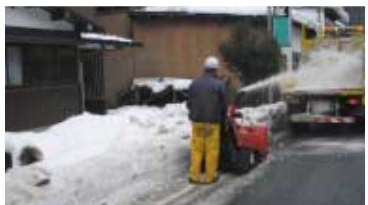
歩道除雪機による道路拡幅作業
