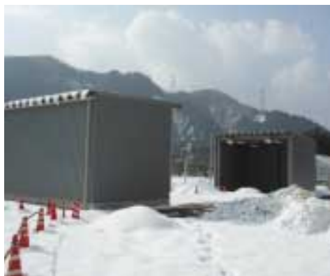
完成間近のピッチングハウス
