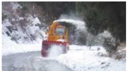
ロータリー除雪車による道路拡幅作業
