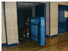
【器具の運び出し】
