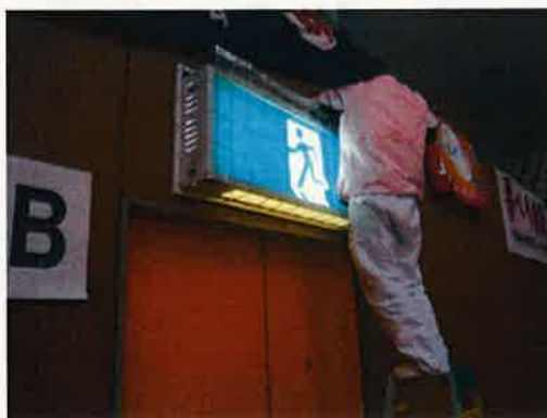
【職員による避難誘導灯の交換】
