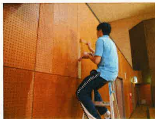
【職員によるアリーナの壁補修】
