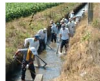
水路の泥上げ
