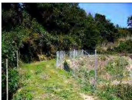
▲共同作業で金網柵を設置
