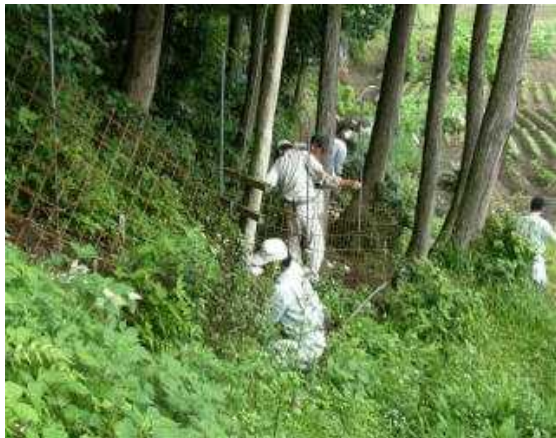
▲共同作業で侵入防止柵を設置（県事業活用）
