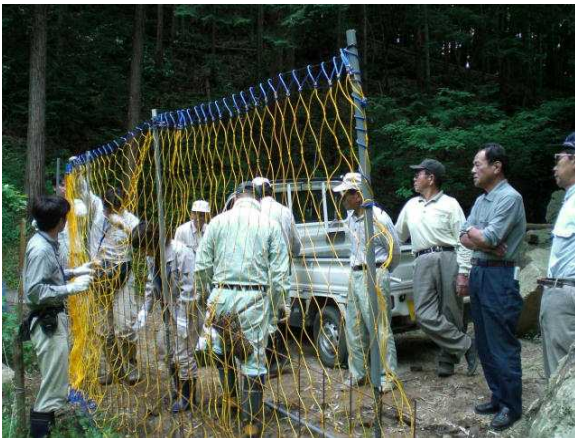
▲イノシシ・シカ侵入防止柵を試験的に組み立て
