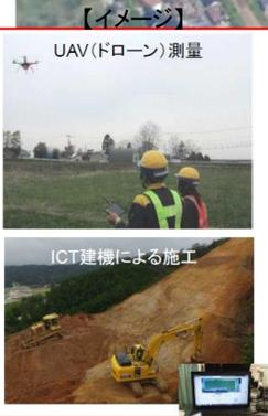
東浜工区では、大規模な山切りや盛土などの土工の施工が、今後本格的に始まります。これらの工事では、ICTの新しい技術を使った土工の工事が行われます。
