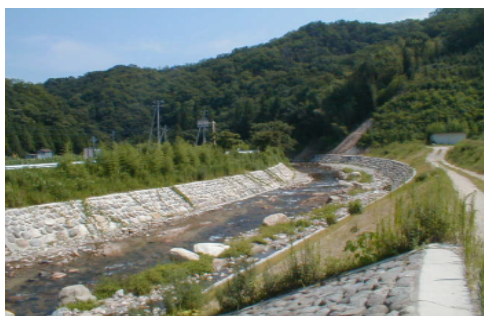
図4 加茂川の中流域の下谷地区下谷橋付近
