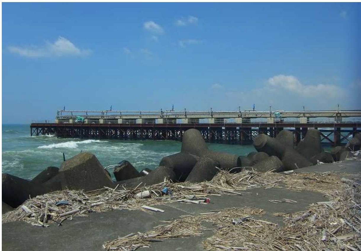
2012/08/07 栈橋全体状況 西防波堤から臨む
