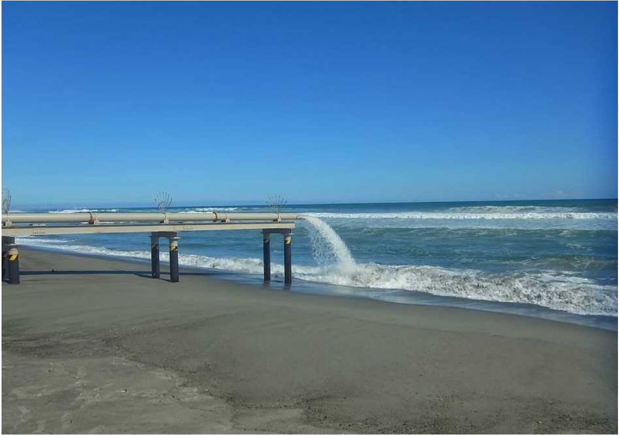
2012/08/24 水運轉 送水状況 1
