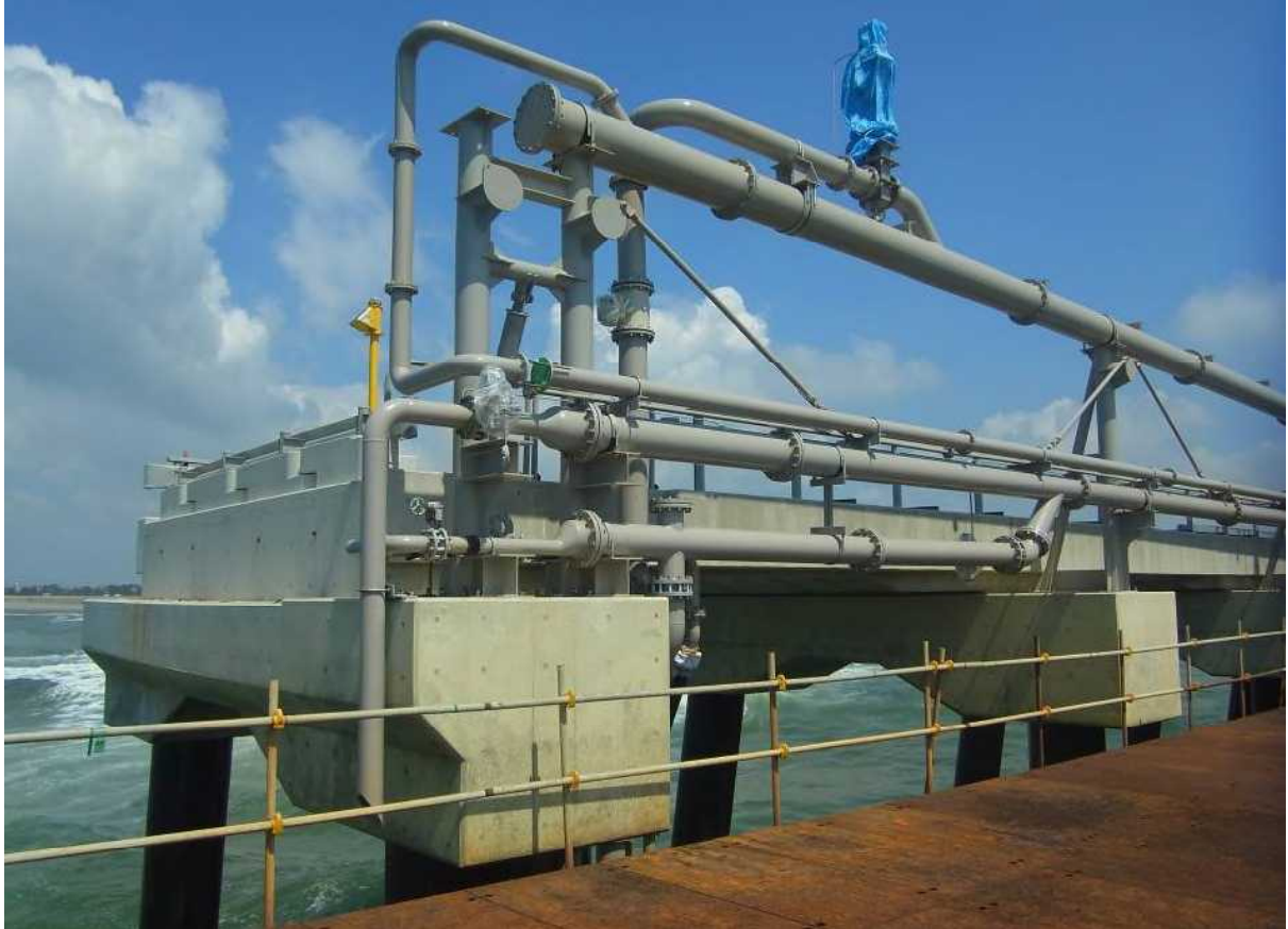
2012/08/07 配管状況 1 仮設栈橋上から臨む
