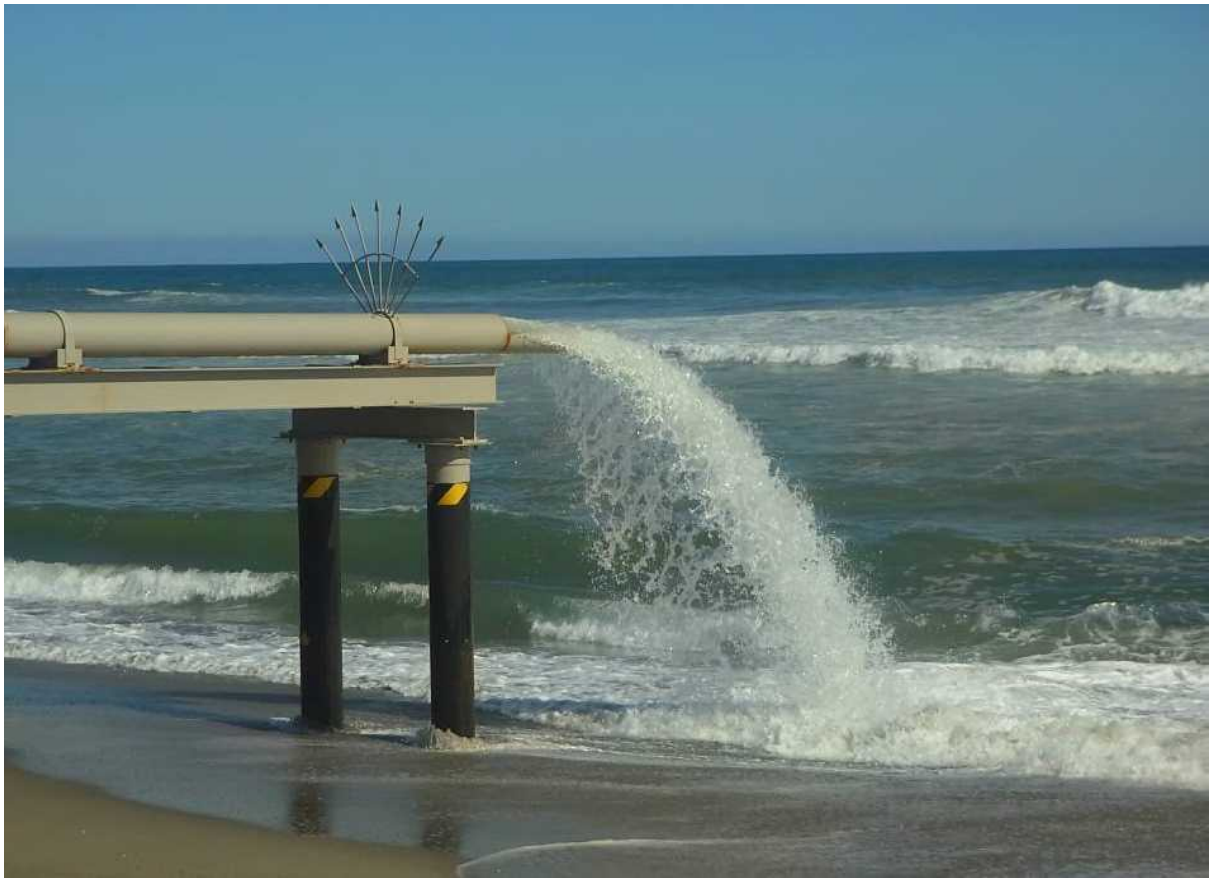
2012/08/24 水運轉 送水状況 2
