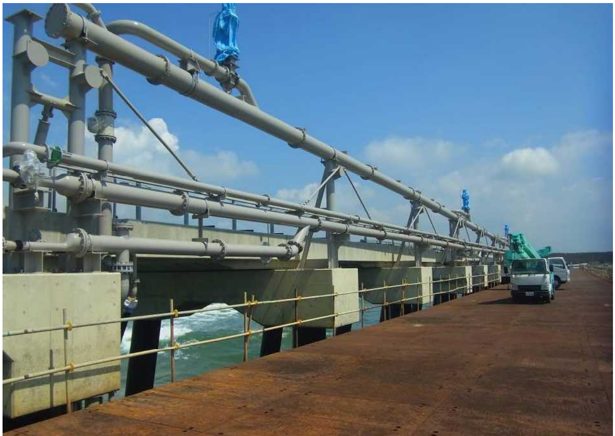
2012/08/07 配管状況 2 仮設栈橋上から臨む
