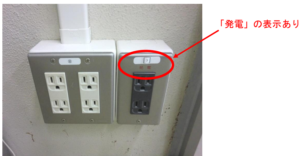
図 2.9 第二庁舎非常用電源コンセントの例（右側が非常用電源）
