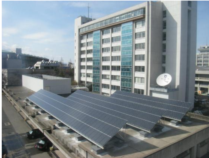
【鳥取県庁太陽光発電システム】
