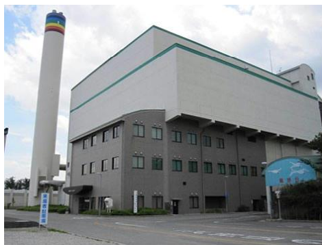
【米子市クリーンセンター（蒸気タービン発電）】
