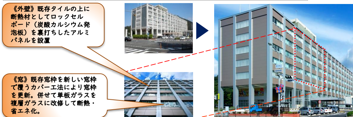
<図1-4> 外壁・建具改修時の断熱化の例
